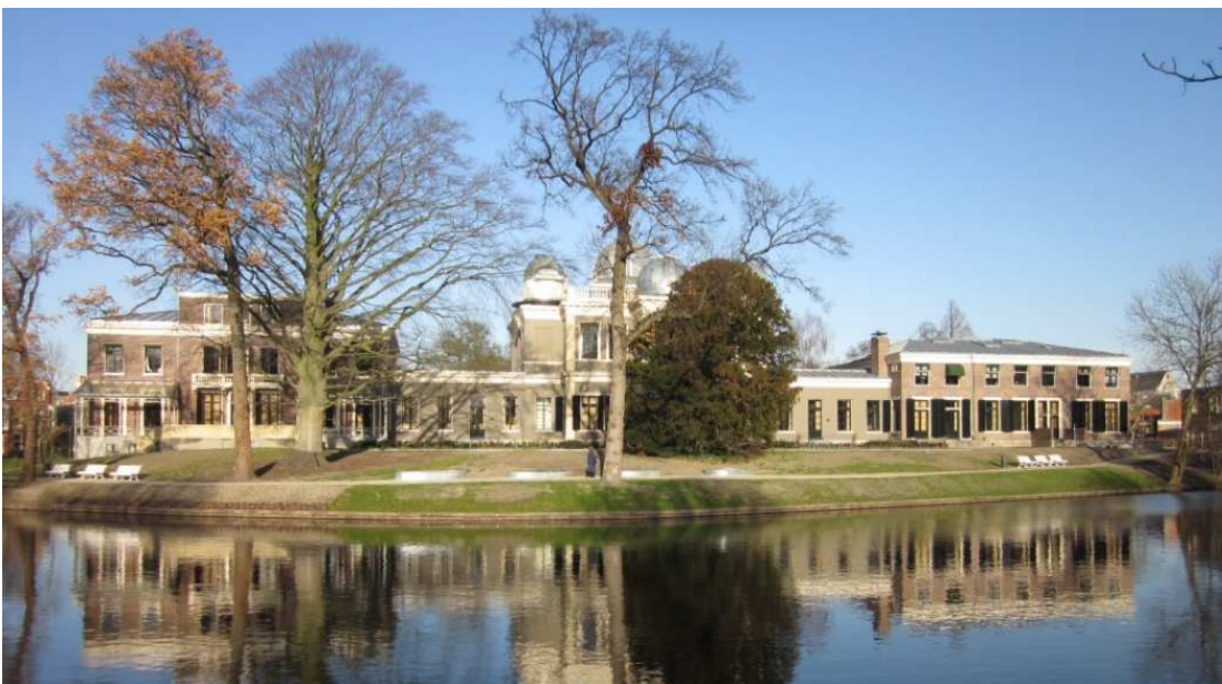
Na de restauratie (2009-2011) De Oude Leidse Sterrewacht
